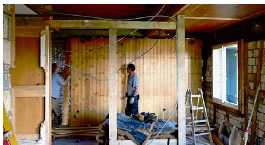
Schicht um Schicht werden die Wände abgetragen.
